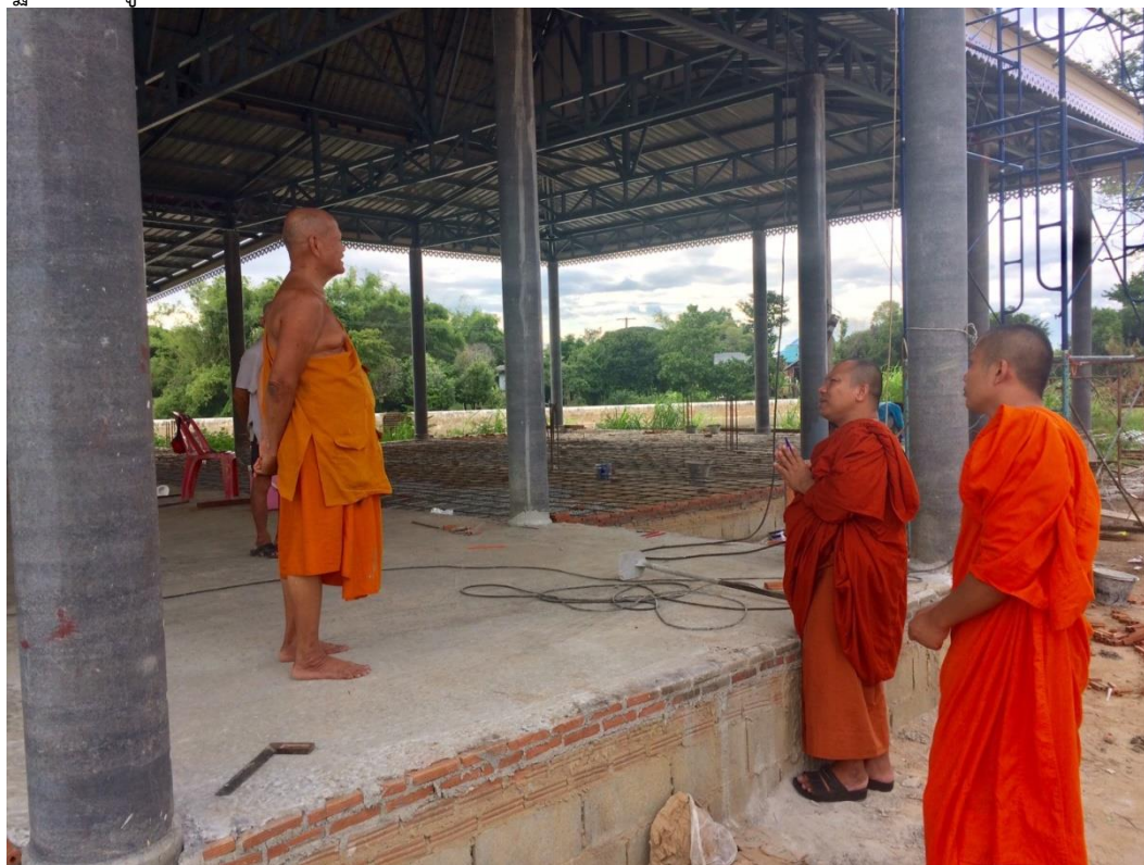
ภาพ 7 พระครูชินธรรมมาภรณ์ (ประยูร ชินปุตโต) เจ้าอาวาสวัดสี่กุก ขณะให้ข้อมูลผ่านการเล่าเรื่อง และกำลังตรวจคุมงานศาลาคู่เมรุ ที่ควบหลายตำแหน่ง เจ้าอาวาส เจ้าสำนักปฏิบัติธรรม และโฟร์แมนคุมงานก่อสร้าง (ภาพ สุวัฒน์ รักขันโท, 23 สิงหาคม 2562)
